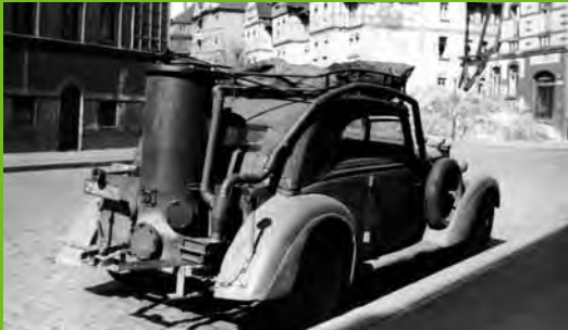
Holzvergaser statt Kraftstoffmotor, 1940er Jahre
