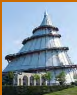
Jahrtausendturm in Magdeburg – höchstes Holzgebäude Deutschlands
