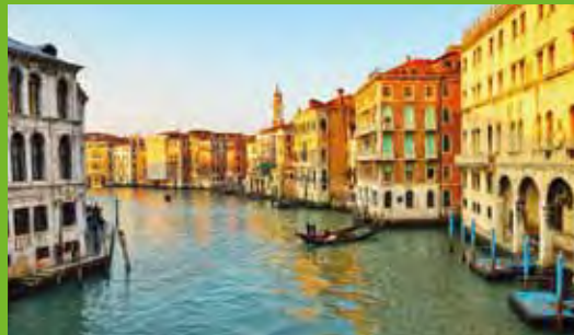
Auch Venedig steht auf Holzpfählen
